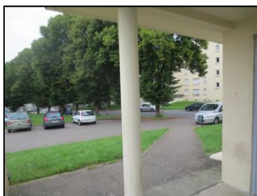
Photo N° 1090 AMIANTE CIMENT -- HALL EXTERIEUR Poteaux Coffrage perdu
